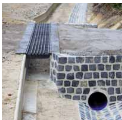
Speciale oplossing: gescheiden waterafvoer
