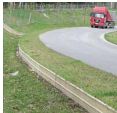
Installatie in de berm
