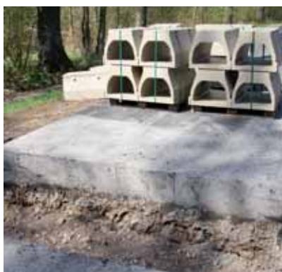
Vorbereiden sleuf in wegdek t.b.v. de tunnel (in een bestaande weg)
