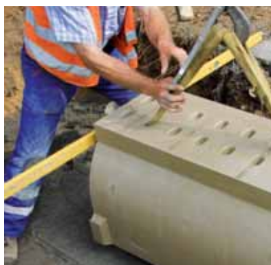
Het plaatsen van de tunnel. Dit kan d.m.v. een blokkenklem of strop.
