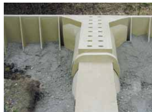
Stellen op betonfundering volgens ACO inbouwvoorschrift
