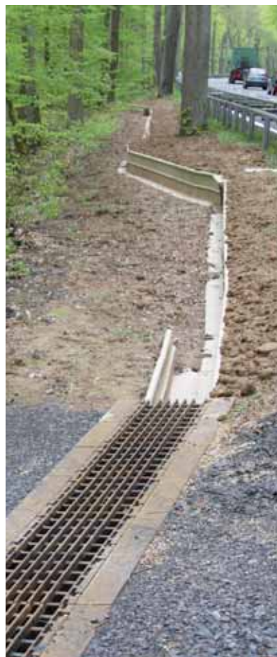
Montage in een grindpad
