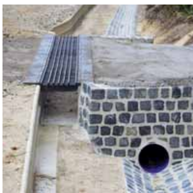
Speciale oplossing: gescheiden waterafvoer
