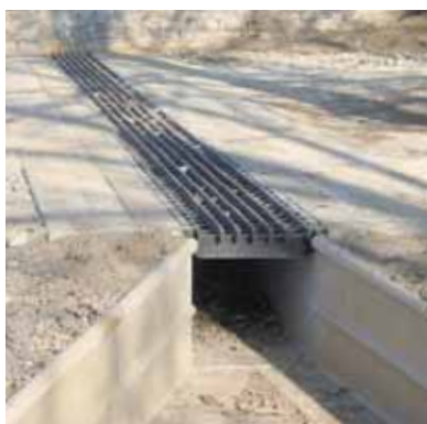
Opvanggoot aangestraat met tegels
