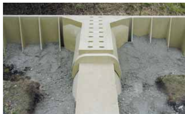
Stellen op betonfundering volgens ACO inbouwvoorschrift
