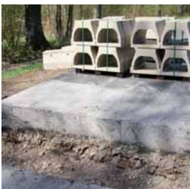
Vorbereiden sleuf in wegdek t.b.v. de tunnel (i.g.v. bestaande weg)
