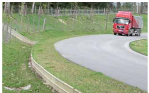
Installatie in de berm
