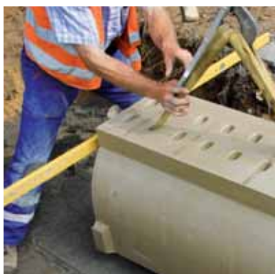
Het plaatsen van de tunnel. Dit kan ook d.m.v. een blokkenklem.
