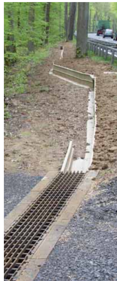
Montage in een grindpad
